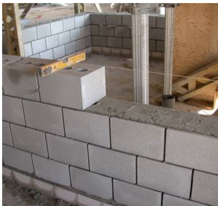
Stadtwerke Krefeld - Neues Treppenhaus - Bredero Modulblock 29 x 24 x 19 cm (lxbxh) grau 100 - glatt
