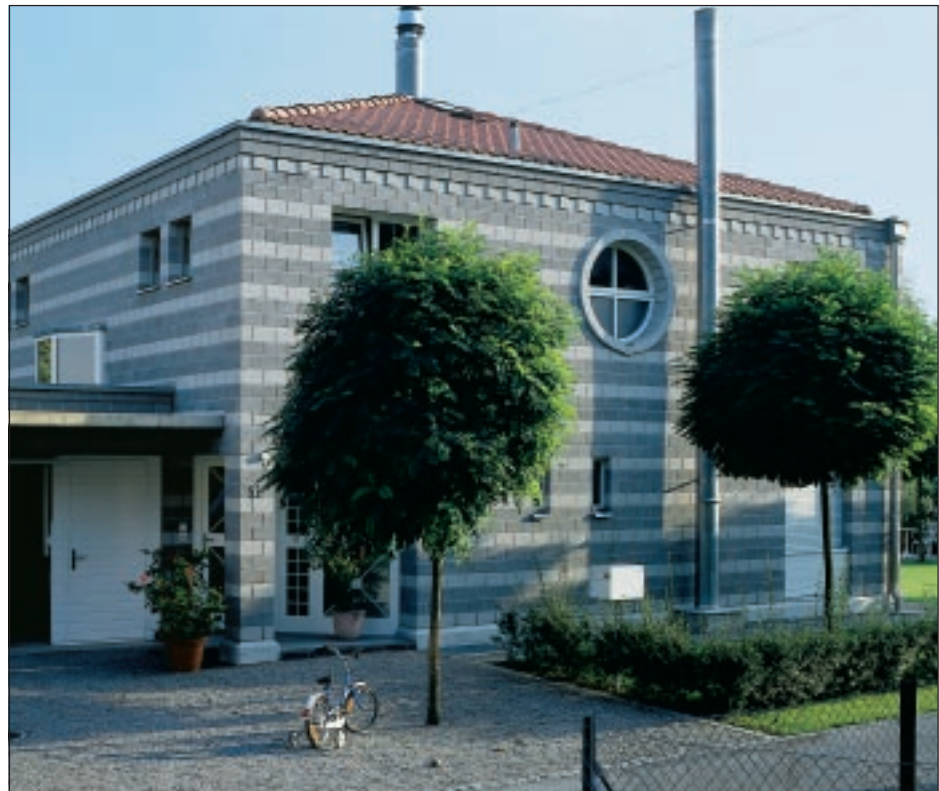
Bild 1: Verwaltungsgebäude/ Bürogebäude/Wohnhaus mit Sichtmauerwerkfassade
